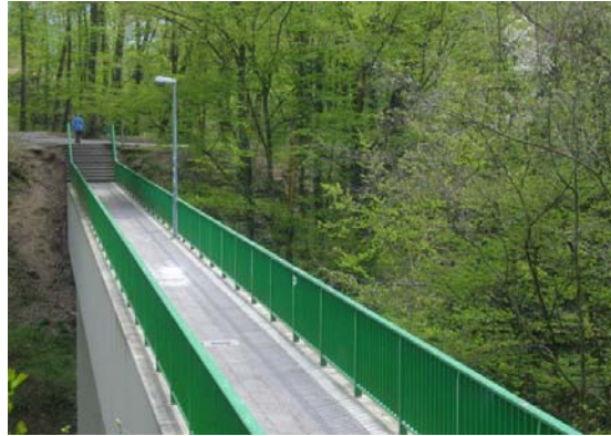
Image 10 : passerelle menant au Lignon
