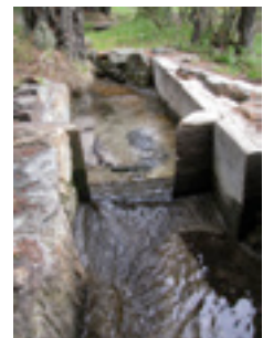
Bisse avec vanne pour diriger l'eau dans les canaux de distribution
