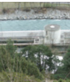
La station d'épuration de Stalden
