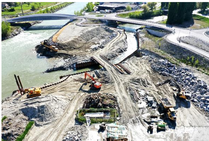
A Viège, d'importants travaux ont permis d'élargir l'embouchure de la Vispa, la rivière qui draine les eaux des vallées de Saas et de Zermatt. Il s'agit de la première intervention de ce type réalisée sur un affluent du Rhône et de surcroît le plus important. Cet élargissement amène une plus-value significative pour la nature et le paysage tandis que la presqu'île créée à l'amont de l'embouchure sera dédiée aux loisirs et à la détente.
