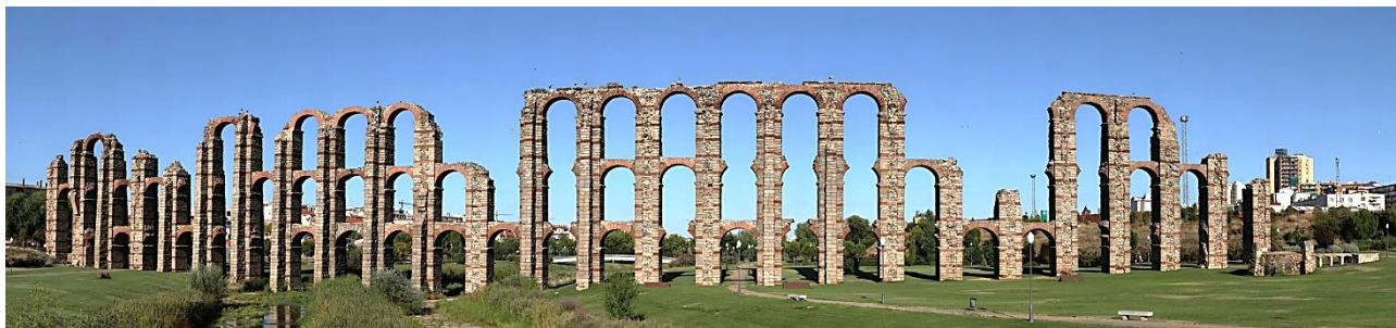
"L'aqueduc des Miracles" fait partie de l'ensemble archéologique espagnol de Mérida, en Estrémadure. Il a été construit dans la seconde moitié du 1 er siècle avant J.-C. pour approvisionner en eau la colonie romaine d'Emerita Augusta. Il a sans doute rempli ce rôle durant trois siècles au moins. [Water Alternatives / Lorenzo Vallès]
